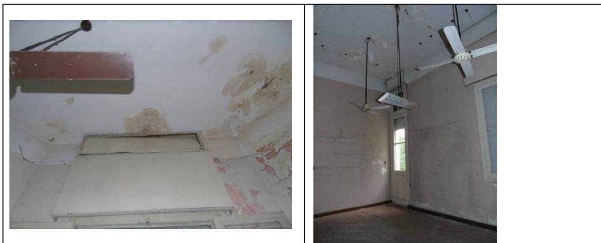
Los cielorrasos de los locales 1, 2 5, 7 y la zona de los pasos, se repararan previamente en un 30% de la superficie del yeso, demoliendo parcialmente los sectores más afectados por humedades antiguas, y reponiendo el yeso mediante yesos especiales y promotores de adherencia tipo Tacurú o similar. En caso de fisuras las mismas podrán ser reparadas con selladores o enduidos plásticos.
