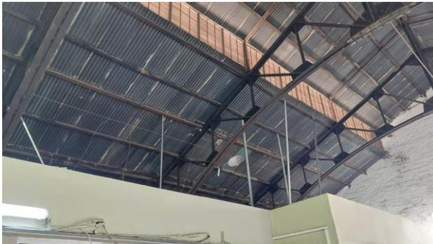
En ésta etapa se deberán retirar las mismas, para ser reemplazadas por una estructura nueva siguiendo las expresas recomendaciones del fabricante de los cielorrasos. Una estructura ordenada tipo armazón o bastidor vinculadas a las cabriadas existentes en dónde se colgarán allí las nuevas velas metálicas soporte de los cielorrasos existentes. Su diseño final deberá ser consensuado y aprobado por la Inspección de la obra.
