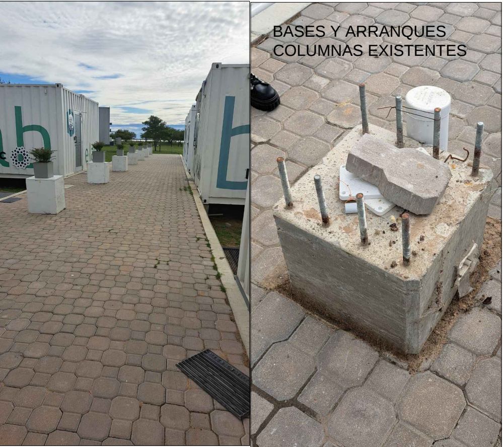
FOTOS SITUACION EXISTENTE PASILLO TECNICO CENTRAL
