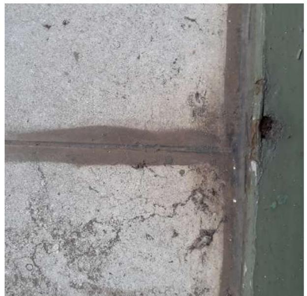
*Ejemplo del estado de las juntas en aberturas. Marco de madera con antepecho de piedra y marco de madera con perfil metálico.*
