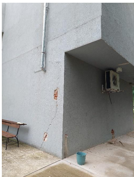
Patología en Voladizo, Pisos y Mamposterías (Exterior)
