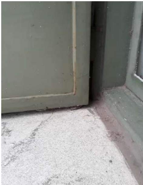
Ejemplo del estado de las juntas en aberturas. Marco de madera con antepecho de piedra y marco de madera con perfil metálico.
