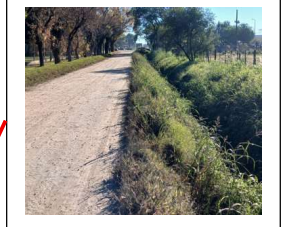
JJ2_canal al este.
