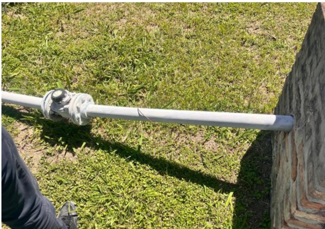
Figura 3 - Ingreso proveniente de la red de ASSA de diámetro nominal (DN) 75 junto con el caudalímetro del mismo diámetro.
