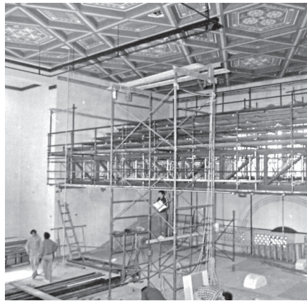
Trabajos en el Paraninfo de la UNL para la Reforma. Hugo Pascucci
