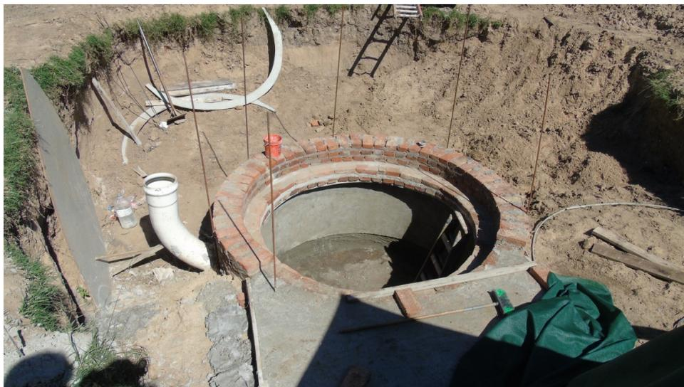
El anillo interior del biodigestor tendrá 4 (cuatro) caños de PVC de 40mm como guía para el gasómetro. Estos caños estarán anclados por dos hierros, uno inferior y otro superior, que están empotrados a la mampostería de ladrillo común (ver corte).
